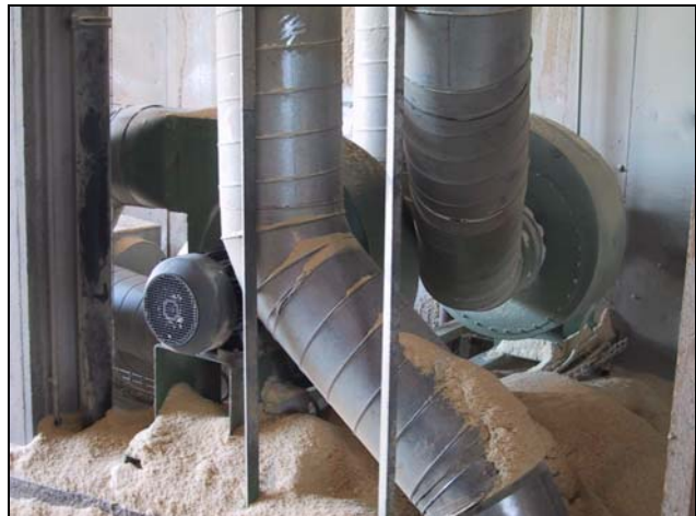
Abbildung 2.23: Die hohen Druckverluste bedingen mehrere Ventilatoren hintereinander.
