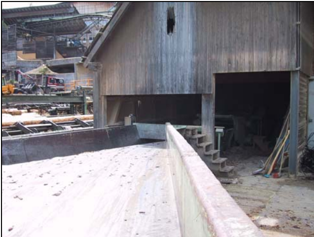
Abbildung 2.5: In der Excentermulde wird das zu hackende Holz aufgegeben. Dieser Aufgabetrichter hat eine Leistung von 18.5 kW
