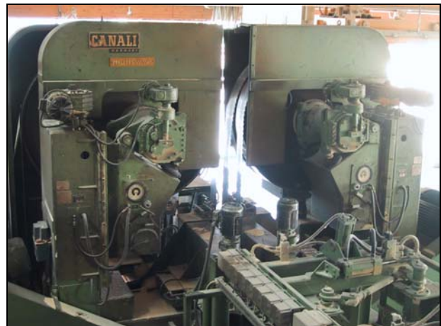
Abbildung 2.10: Bandsägen der Profilerspanneranlage
