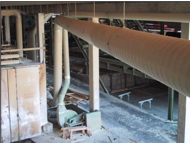
Abbildung 2.22: Ein verzweigtes, langes Netz verursacht hohe Druckverluste.
