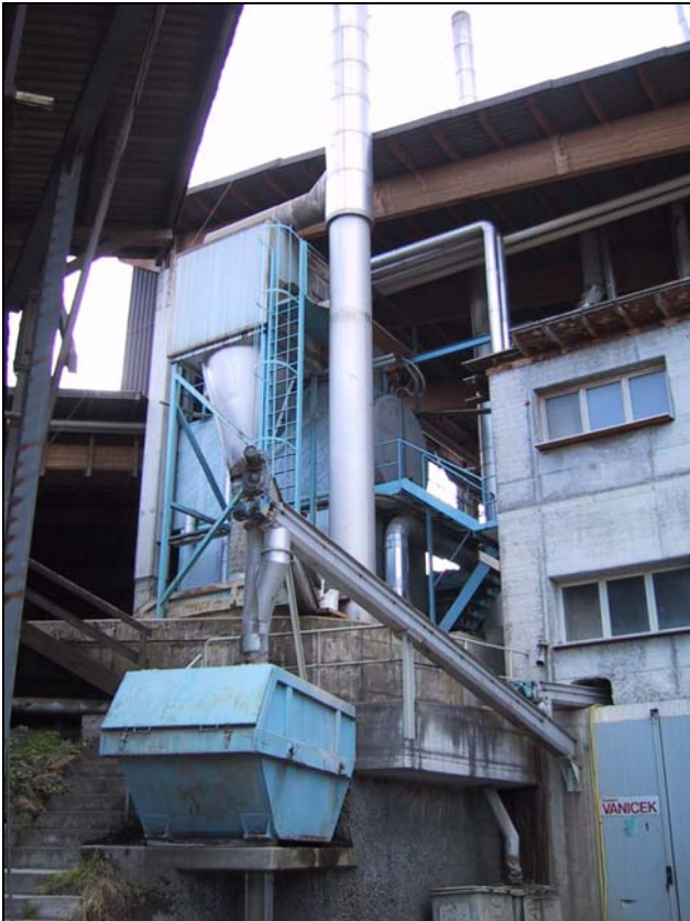
Abbildung 2.25: 5 MW Holzessel mit Zyklonabscheider und Aschemulde.
