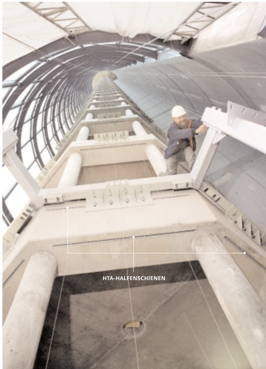
Befestigung des Kraggerüsts an einbetonierten Halfenschielen
