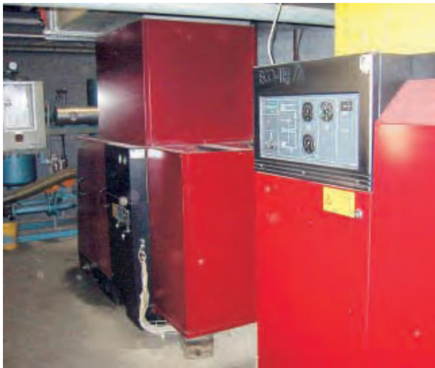
Die Stromkosten der Druckluftanlagen lassen sich um über 78 Prozent vermindern.
