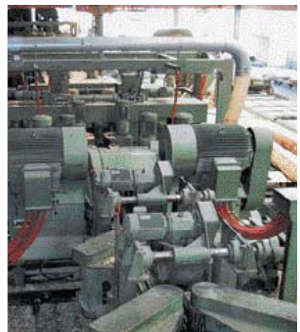
Motoren laufen häufig im Leerlauf. Ein bedarfsabhängiges Schalten lohnt sich.
