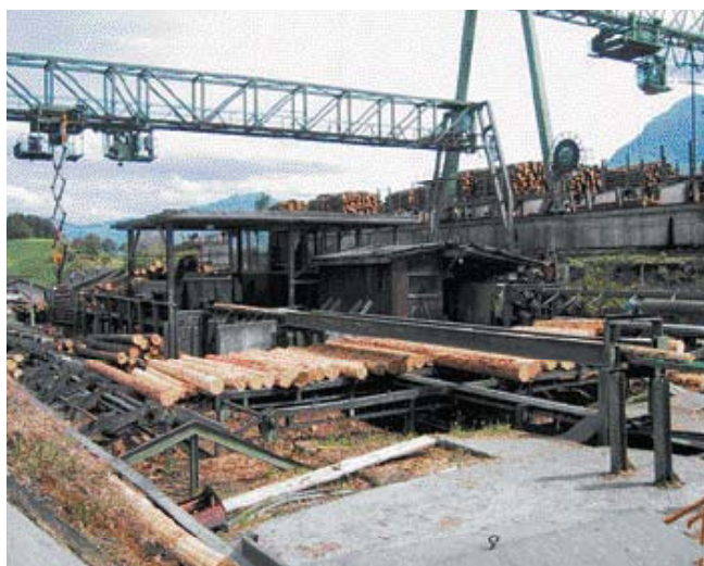
Energierückgewinnung beim Absenken von Lasten.
