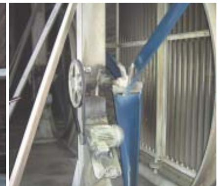
(r.) Ventilatoren in den Trockenkammern. Drehzahlregulierung spart 24 % Energie.
