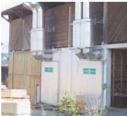
(l.) Die Trockenkammern verbrauchen viel Energie.
