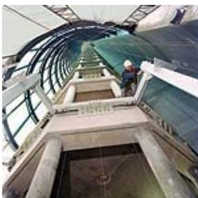
Mitten im Frankfurter Bankenviertel, gleich neben dem Maintower, erhebt sich das Eurotheum. Schindler-Monteur errichteten das freitragende Stahlgerüst im Aufzugturm.
